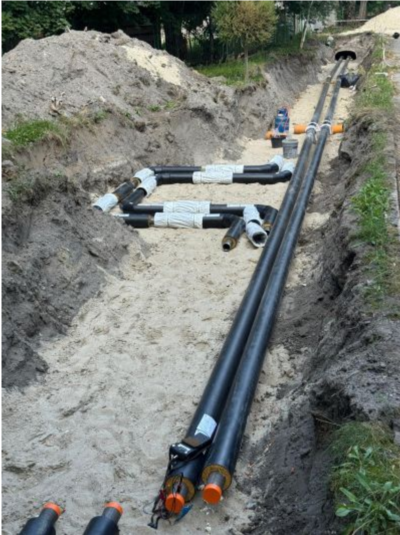
Sieć ciepłownicza
