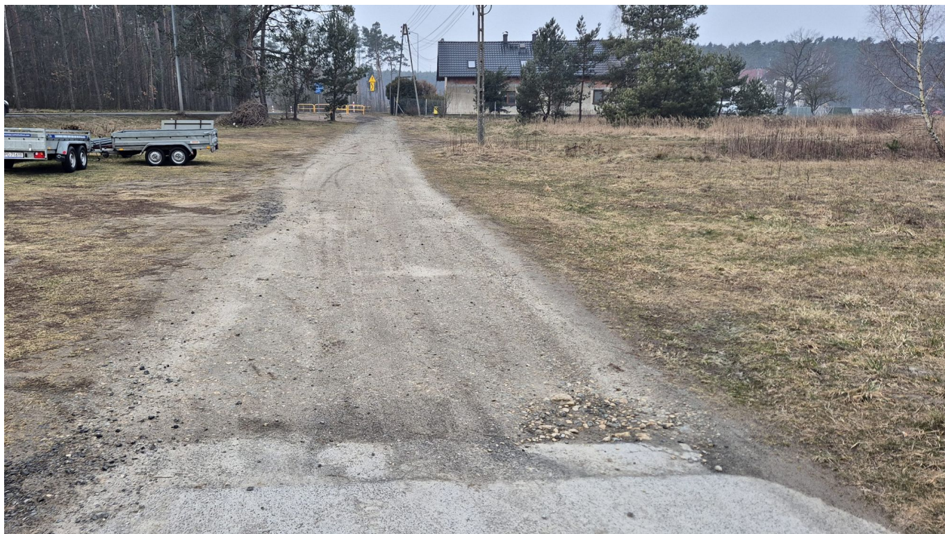
Ulica Opolska w Schodni przed remontem.
