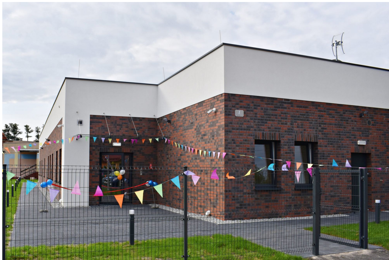
Na zdjęciu nowy budynek przedszkola w Grodźcu
