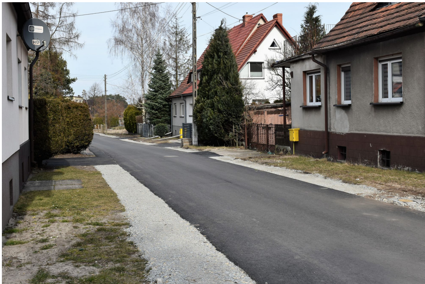
Modernizacja ulic Waryńskiego i Jelenia
